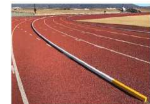
全線に設置した代用縁石【図3】
